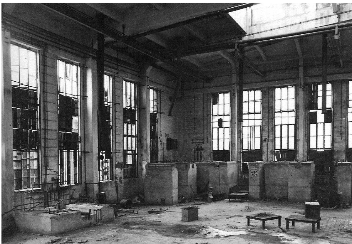
Quelle: Rep. 204A Nr. 2852 (Demontierte Flotation im Vereinigte Aluminiumwerke AG Lautawerk (Kr. Calau)
